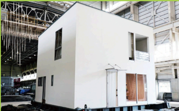
■ワンスキューボは震度7の地震を10回連続で加振実験を実施しました。
